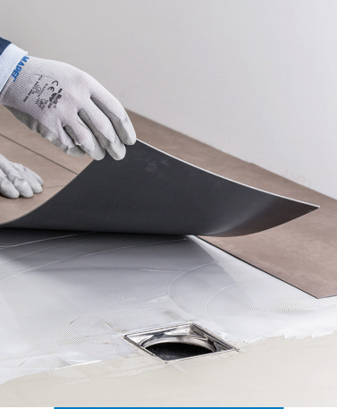
Installering af LVT- belægning med Ultrabond Eco MS 4 LVT i fugtige omgivelser
